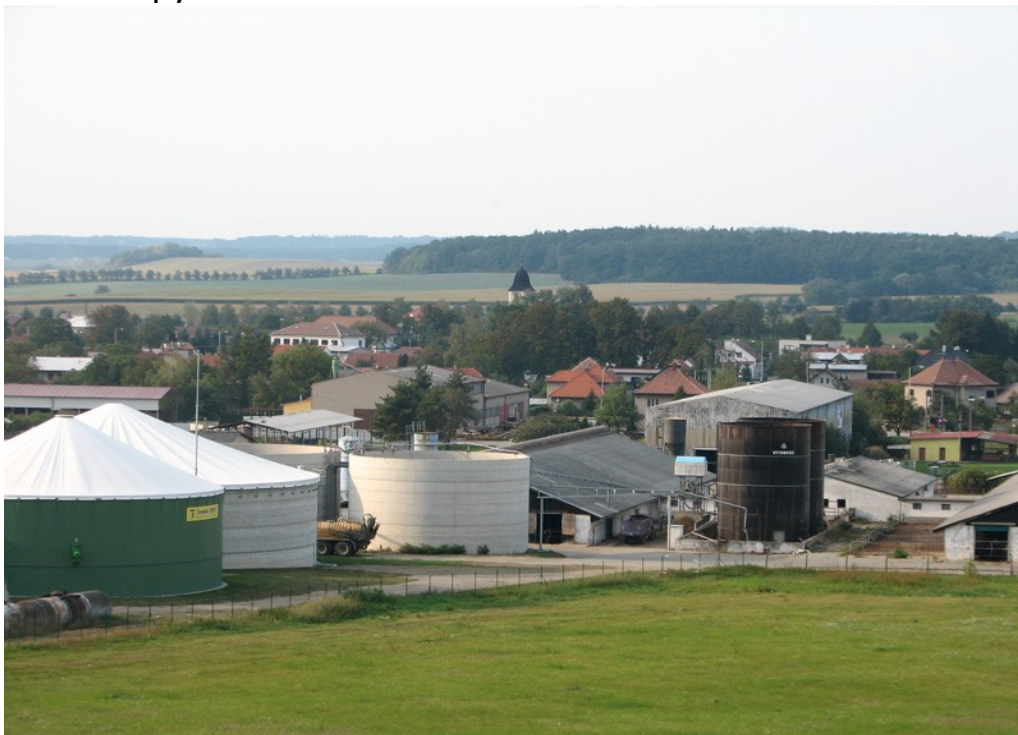
Obr. č. 9: Bioplynová stanice ZD Ostřetín
